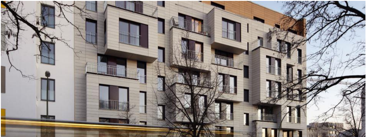
Ein Mehrfamilienhaus in Berlin mit 21 Wohneinheiten – realisiert im Passivhaus-Standard und als Nullemissionshaus. „Passivhaus – nachhaltig die Zukunft bauen!“ ist das Schwerpunktthema der 24. Internationalen Passivhaustagung 2020 in Berlin. © Andrea Kroth
