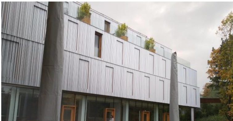
Selbst bei Regenwetter ein Hingucker: Dieses Passivhaus-Hotel im spanischen San Sebastián wurde mit viel Holz errichtet und stand bei einer Exkursion der COP25 in Spanien auf dem Besichtigungsplan. © PHI
