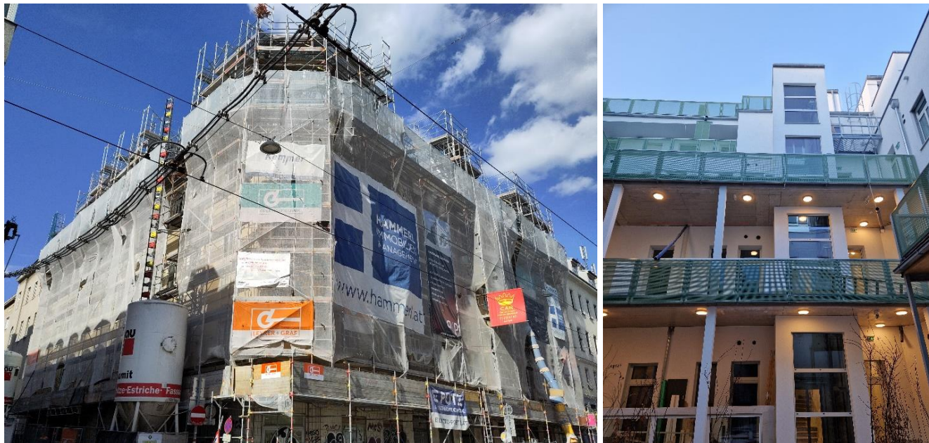
Die 27. Internationale Passivhaustagung in Innsbruck legt den Schwerpunkt auf EnerPHit-Sanierungen: Die Modernisierung dieses Gründerzeithauses in Wien mit Passivhaus-Komponenten ist fast abgeschlossen. © Schöberl & Pöll
