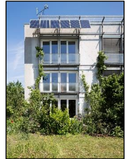
Das weltweit erste Passivhaus in Darmstadt-Kranichstein. © Peter Cook
